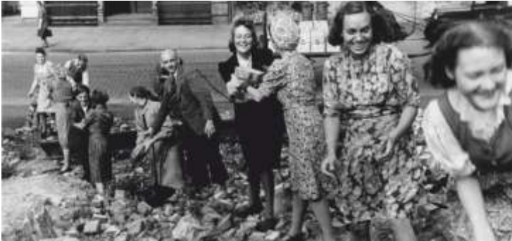
Die Enttrümmerungsarbeiten der Stadt Potsdam hielten noch jahrelang an. Eine tragende Stütze im Wiederaufbau der Stadt Potsdam waren die „Trümmerfrauen“.
